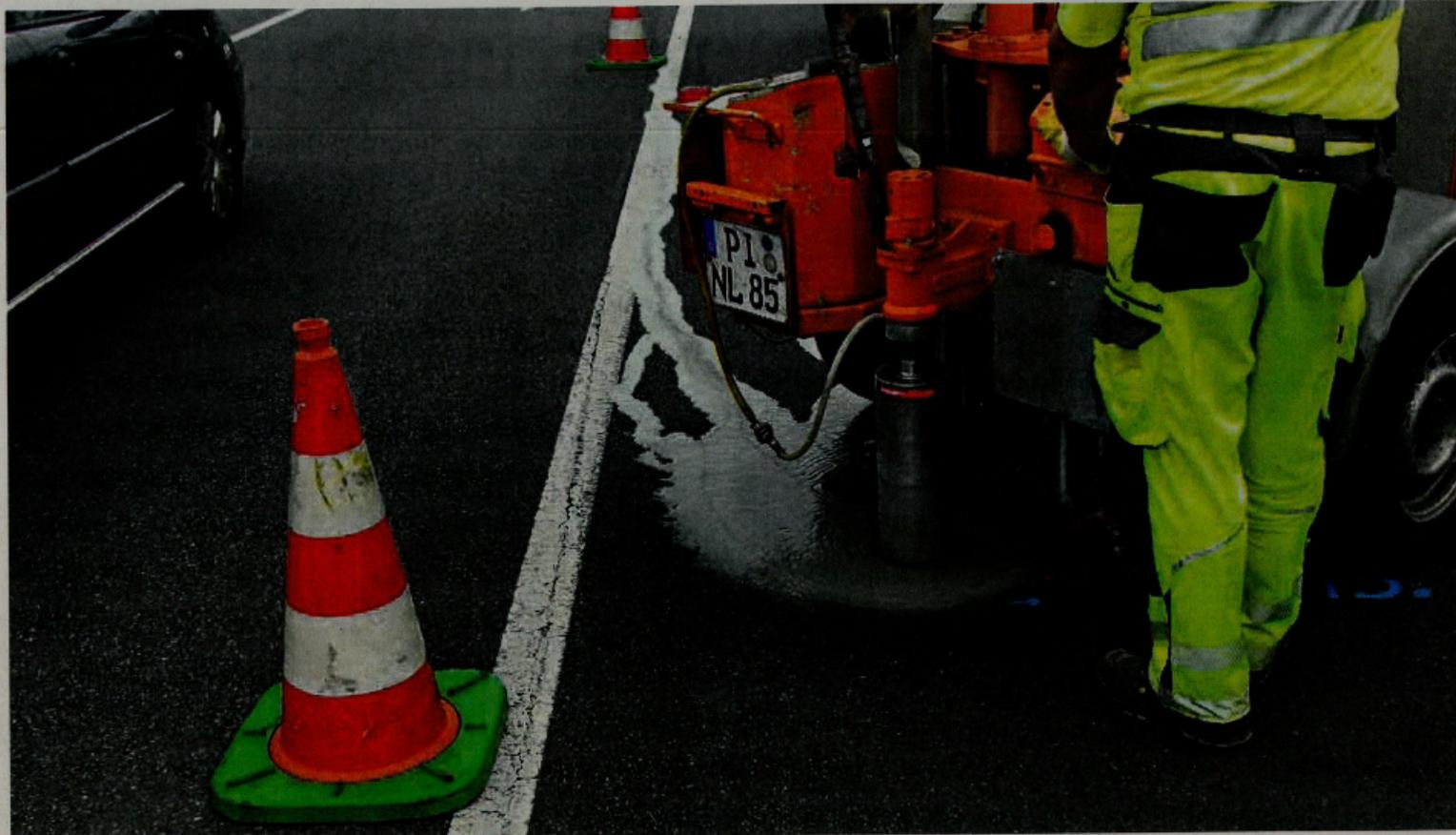
Um die Verkehrstauglichkeit einer Straße zu analysieren, muss das HNL Bohrkernproben nehmen. Baustoffprüfer untersuchen diese später im Labor Fotos: HNL, Matthias Röhrs
