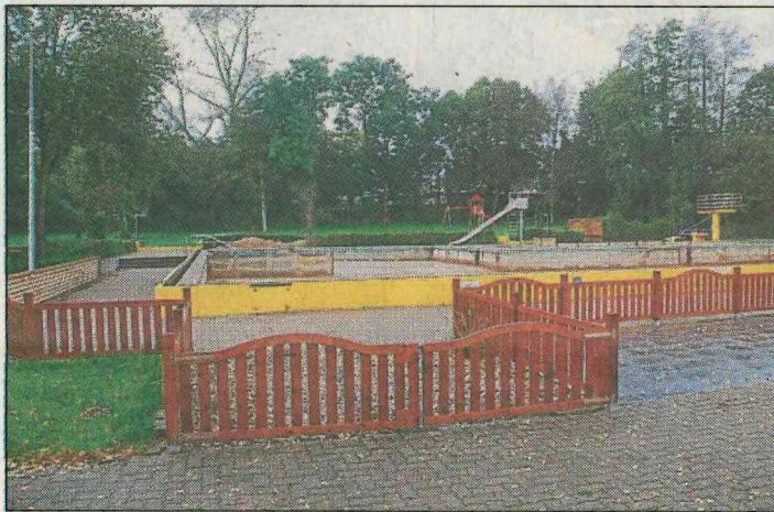
Im Tellingstedter Freibad sind viele Mängel festgestellt worden, die nun zu beheben sind.
